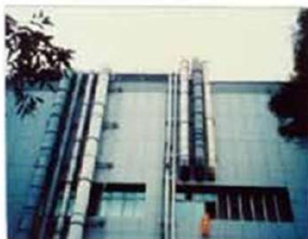
旺宏一廠管路工程
